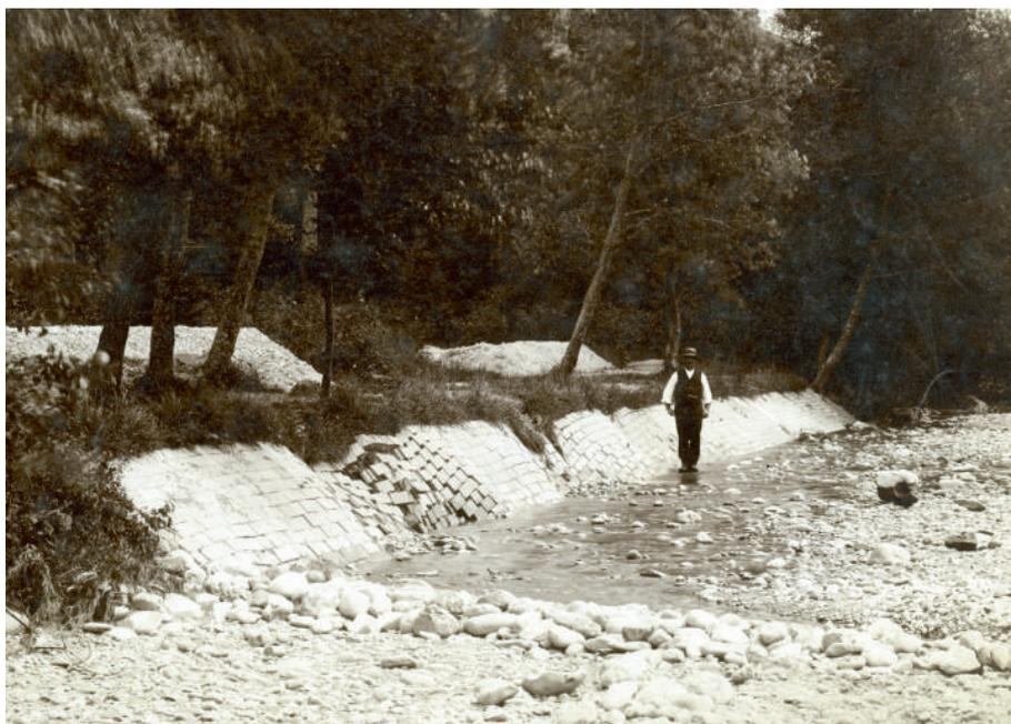
schutz errichtete Décauville'sche Uferverkleidung oberhalb der Müllerschwelle. Im Winter 1911-1912 gebaut, wurde sie durch Hochwasser z.T. zerstört. Im Bild (li) das rechte Zulgufer oberhalb der Müllerschwelle nach den Hochwassern 1912, mit Bauleiter Karlen bei der Schadensbesichtigung.
