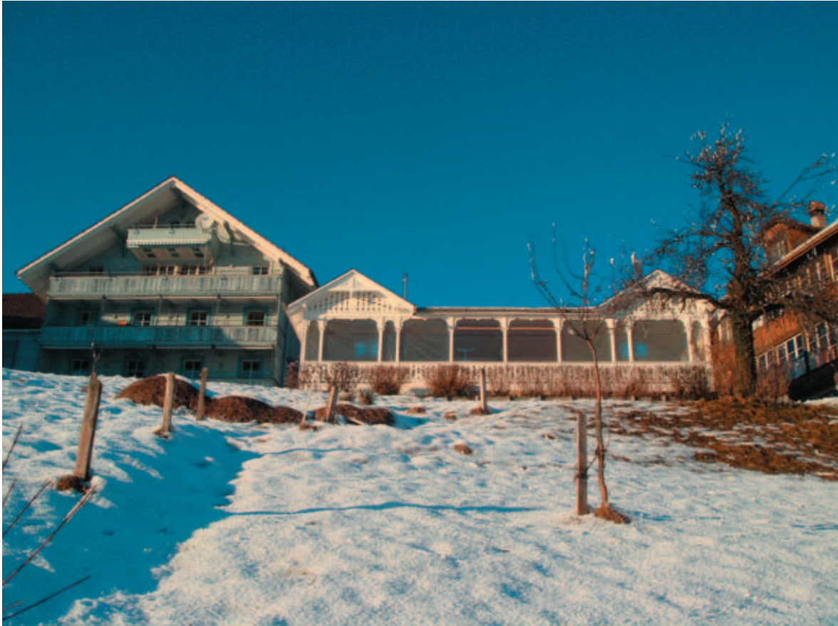
Bild: Im Schweizer Holzstil erbaute Liegehalle (Pavillon) von 1890 des ehem. Sanatoriums Hartlisberg, Stand nach diversen Umbauten und Umnutzungen. Aufnahme vom Januar 2009.
