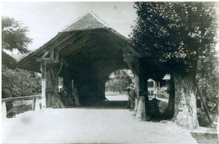
Dorfbrücke (mit Brückenzoll) über die Zulg in Steffisburg, 1765-1886; die Holzbrücke hat allen Hochwassern standgehalten.
