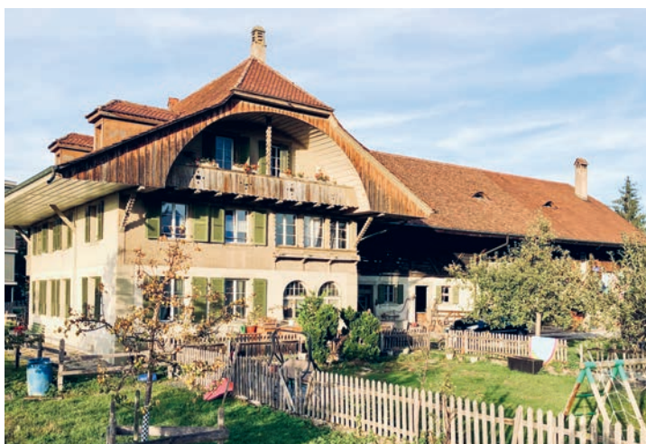
eh. Wohnhaus des Pulvermachers & Produktionsgebäude / Ansicht 2023
